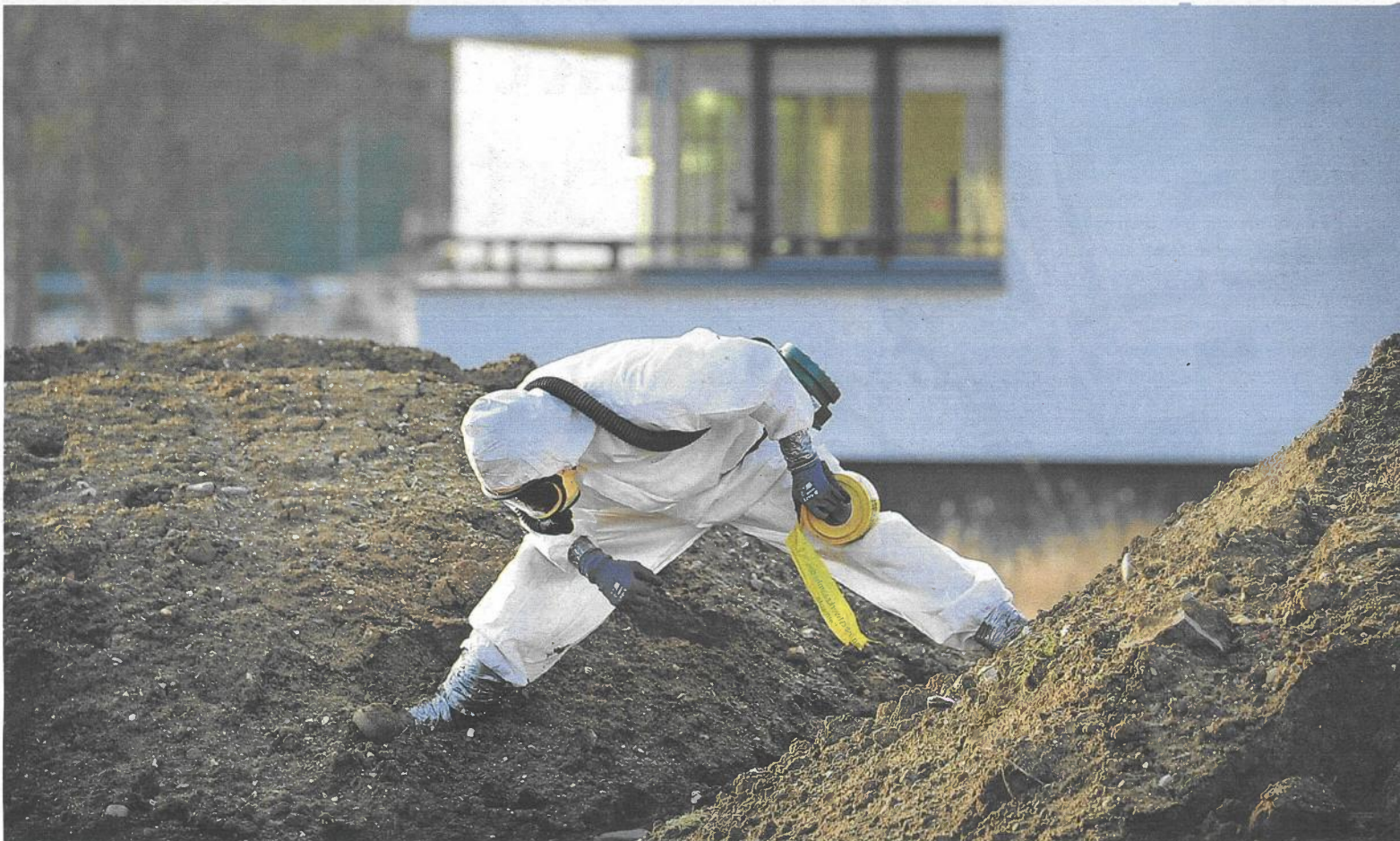
Opruimwerkzaamheden na asbestbrand in Roermond in 2014. Archiefphoto: Hollandse Hoogte
