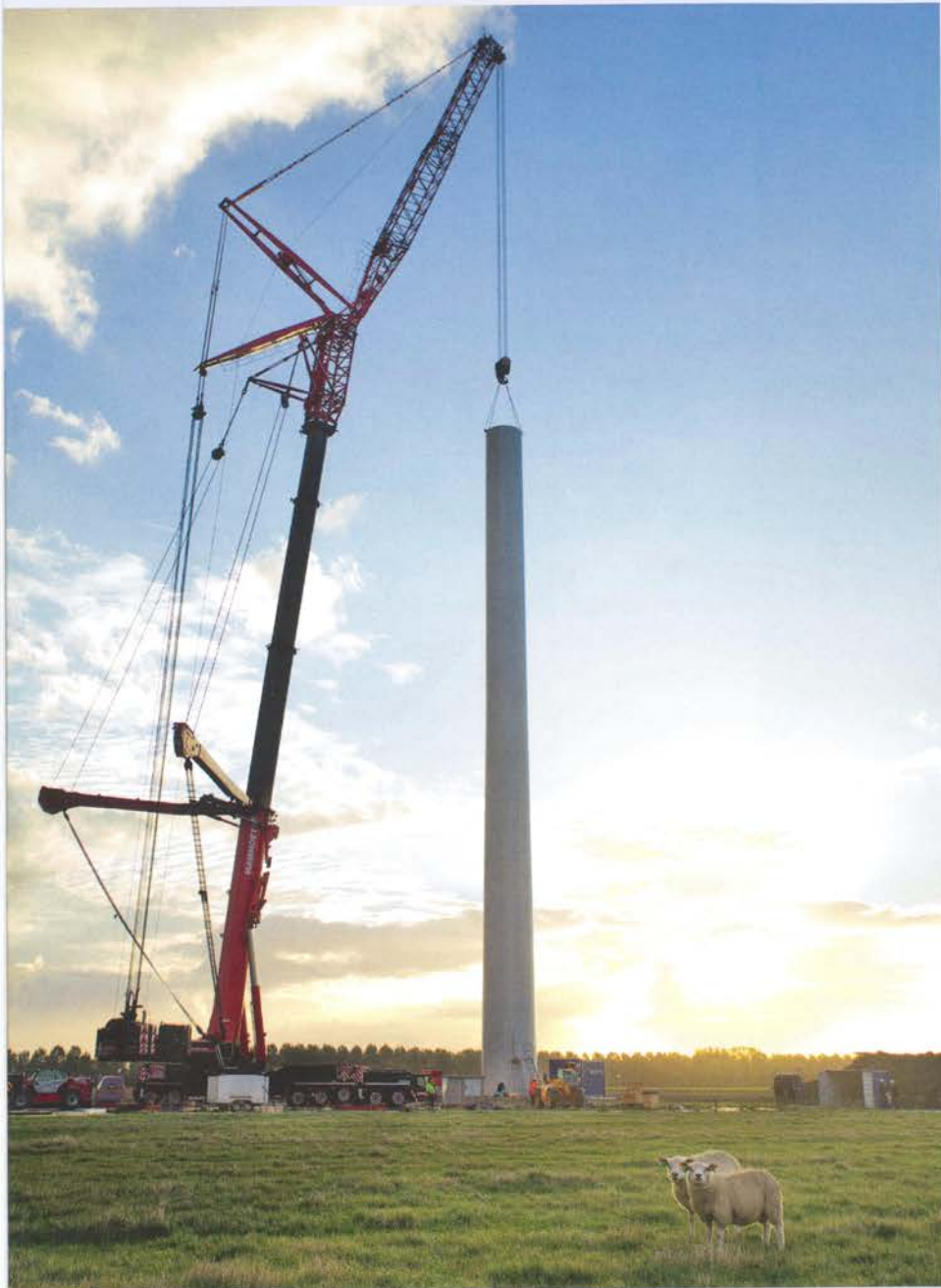
Windmolen in aanbouw op het Alexia Windpark in Zeewolde. Beeld Jorrit Lausberg
